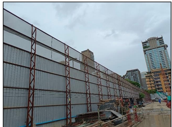
รูปที่ 2-1 รั้ว Metal Sheet
